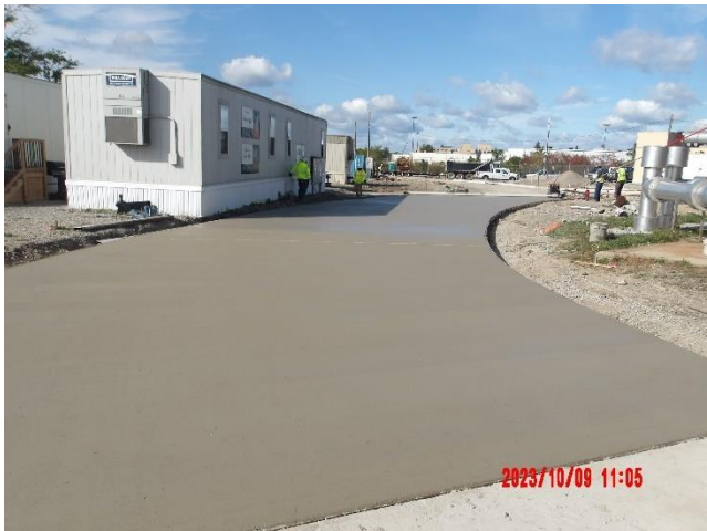
Concrete pavement pour (Phase II)
