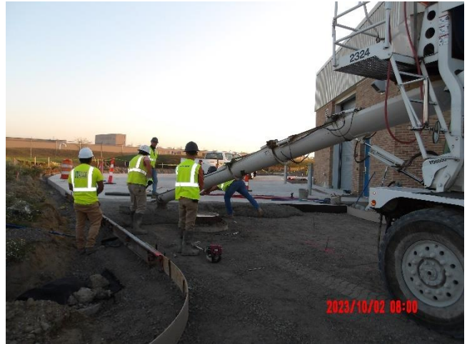
Concrete pavement pour (Phase I)
