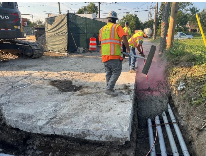
Encasing electrical conduits
