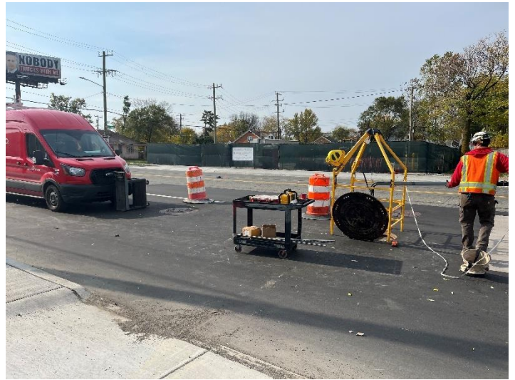
Conduit installation
